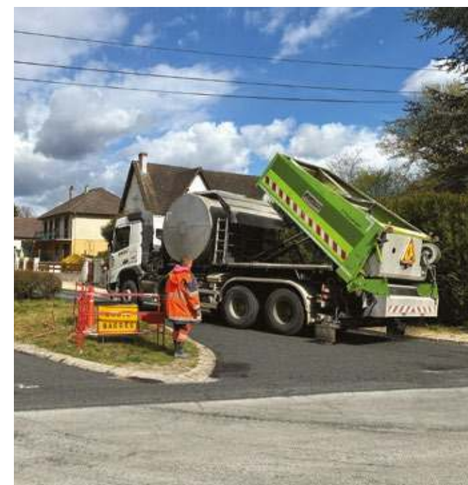
Travaux de voirie.
