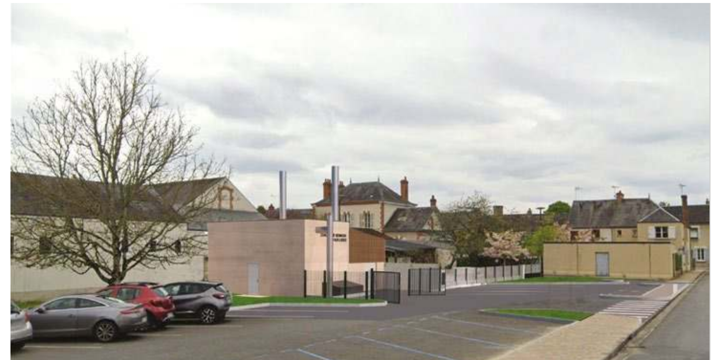
Projet de construction de la chaufferie centrale biomasse.
