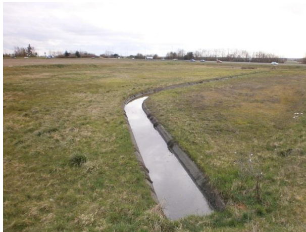
Bassin de rétention avec étanchéité par argile compactée + engazonnement
