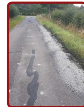
Enfin, sur la route du Gué Girault, où la chaussée était très déformée, des travaux plus lourds ont été entrepris en reprenant totalement la structure sous la chaussée, avant de refaire le revêtement final de la voirie. En 2022, nous poursuivons ces travaux afin de terminer la réparation de la structure aux autres endroits de cette route.
