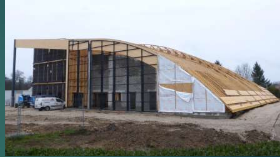
Gymnase de Fay en construction
