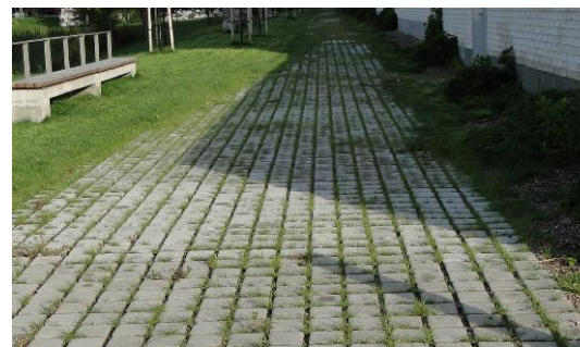
Voie douce avec gestion de l'infiltration des eaux de pluie – Quartier Vikki - photographies parenthesesURBaines
