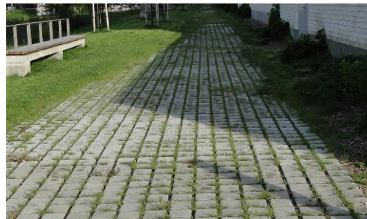
Voie douce avec gestion de l'infiltration des eaux de pluie – Quartier Vikki - photographies parenthesesURBaines
